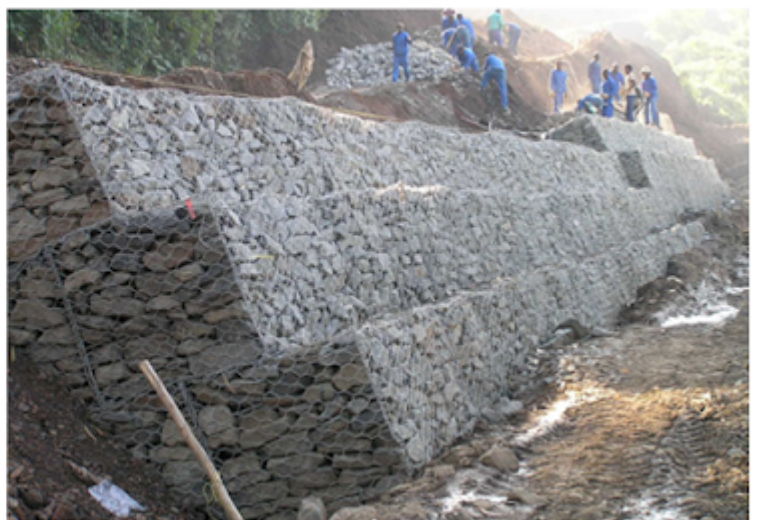
Gambar 6. Struktur Dinding Penahan Bronjong
