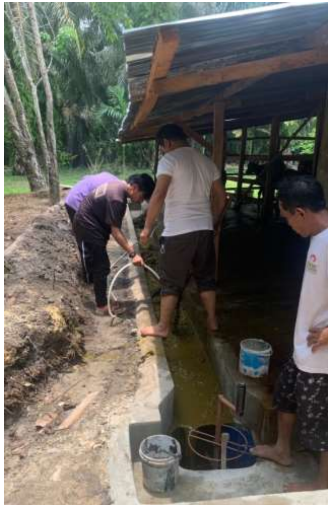
Gambar 19 warga bergotong-royong mengisi reaktor biogas pada hari pertama
