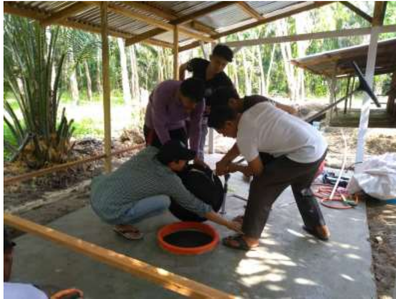
Gambar 13 proses penutupan reaktor biogas
