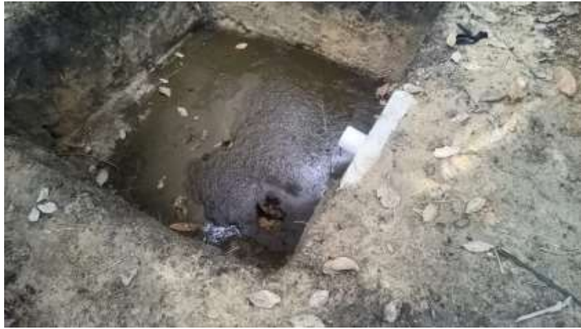
Gambar 23 kolam penampungan ampas biogas
