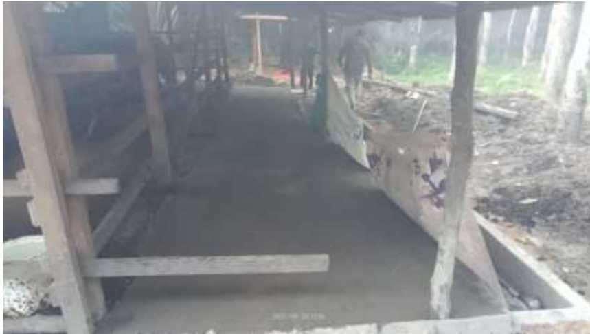
Gambar 36 Penyemenan lantai penghubung bagian pengadukan
