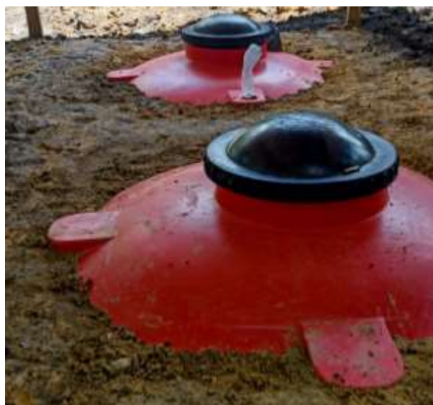
Gambar 39 Pemasangan reaktor biogas
