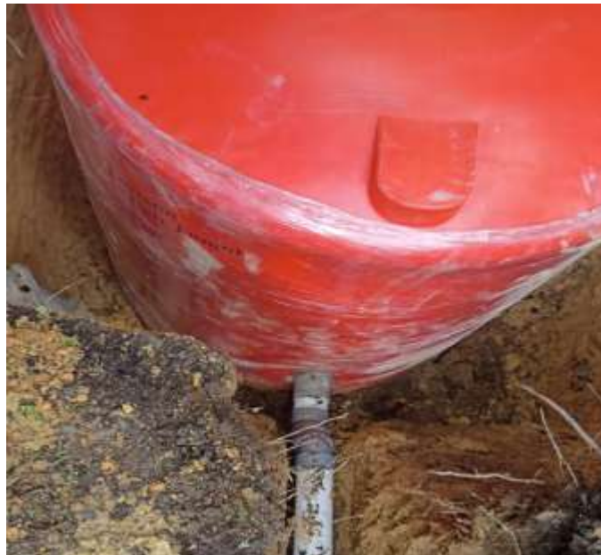
Gambar 11 pemasangan pipa input denagn diameter 4”
