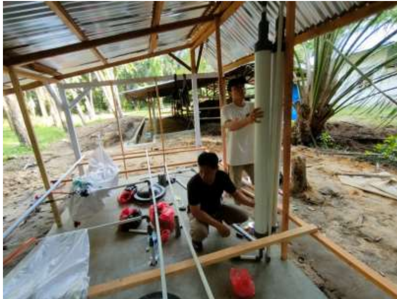
Gambar 33 Pemasangan pemurnian biogas pada bangunan atas reaktor biogas
