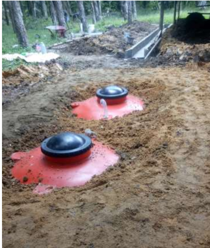
Gambar 32 Lahan yang digunakan untukpembaunan reaktor biogas
