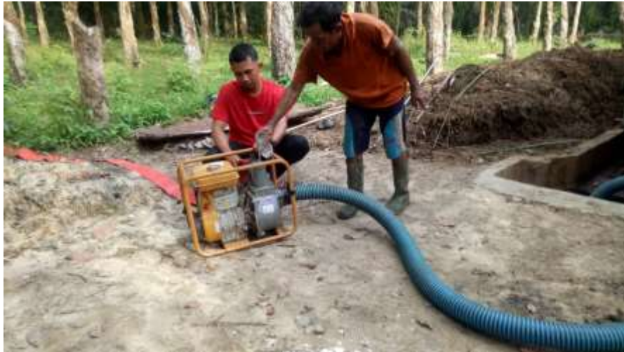
Gambar 48 Penyedotan akibat terjadi sumbatan pada pipa masuk dan pipa keluar dari reaktor biogas
