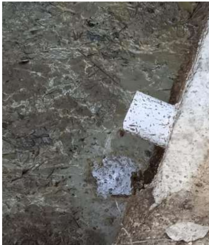
Gambar 40 Penyumbatan di bagian pembuangan reaktor biogas dikarenakan kekurangan air
