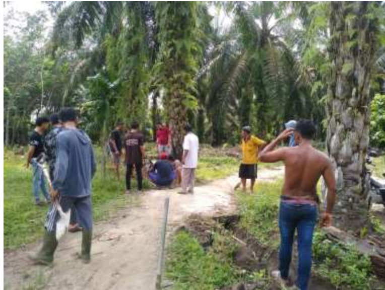
Gambar 22 gotong-royong pemasangan pipa distribusi biogas
