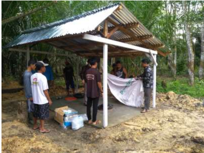
Gambar 16 pemasangan balon penampungan biogas
