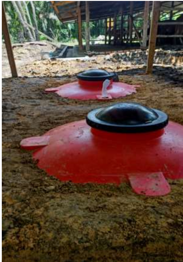
Gambar 12 pemasangan reaktor biogas
