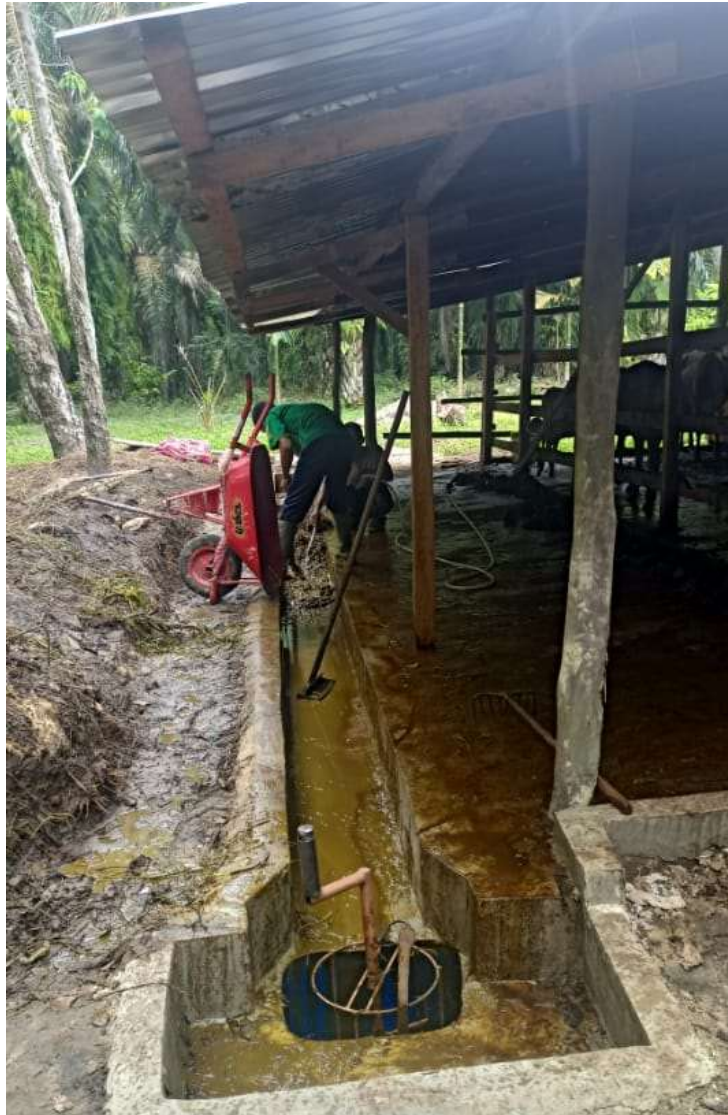
Gambar 20 hari ke-3 warga mengisi reaktor biogas
