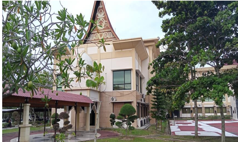
Gambar 5. 17 Split Levels pada Gedung Kantor Bidang Ekonomi, Pembangunan dan Kesra Kampar
