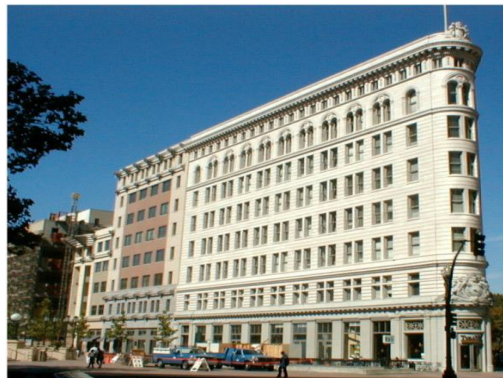
Gambar 3. 10 Ilustrasi bangunan tidak berparalel Sumber : (FEMA P-154, 2015)
