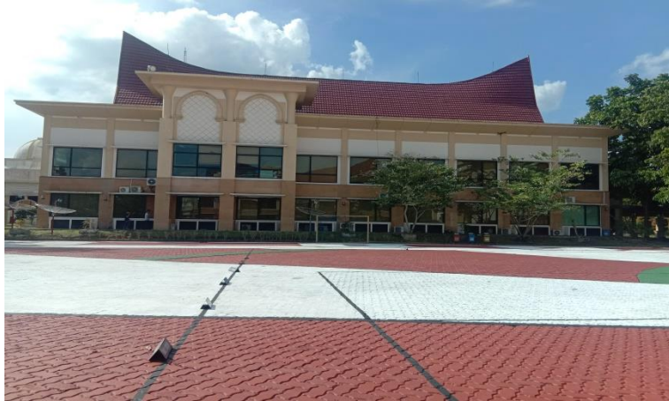
Gambar 5. 11 Gedung Kantor Bidang Ekonomi, Pembangunan dan Kesra Kampar
