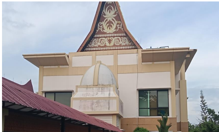
Gambar 4. 29 Parapets pada bagian atap Gedung Kantor Tata Pemerintahan, Hukum, dan Politik Kampar
