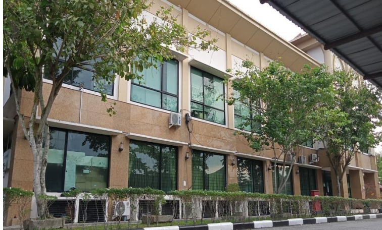
Gambar 4. 23 Heavy Cladding or Heavy Veneer pada Eksterior Gedung Kantor Bidang Ekonomi, Pembangunan dan Kesra Kampar
