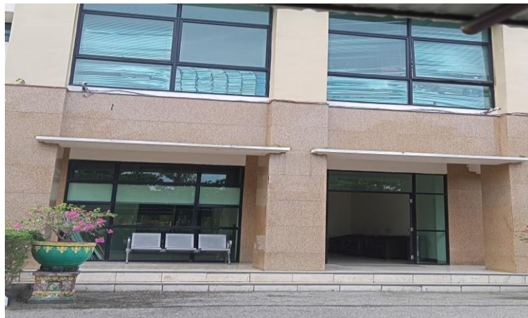
Gambar 4. 31 Heavy Cladding or Heavy Veneer pada Eksterior Gedung Kantor Tata Pemerintahan, Hukum, dan Politik Kampar
