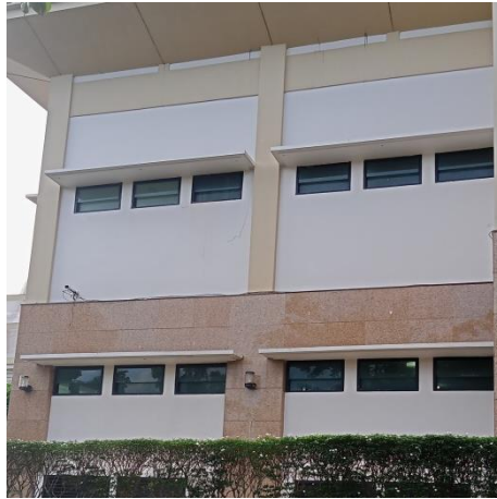
Gambar 4. 32 Kanopi pada jendela Eksterior Gedung Kantor Tata Pemerintahan, Hukum, dan Politik Kampar
