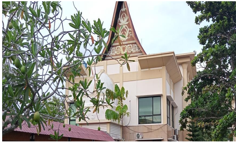
Gambar 5. 21 Parapets pada bagian atap Gedung Kantor Bidang Ekonomi, Pembangunan dan Kesra Kampar
