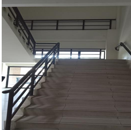
Gambar 4. 30 Parapets pada tangga Gedung Kantor Tata Pemerintahan, Hukum, dan Politik Kampar
