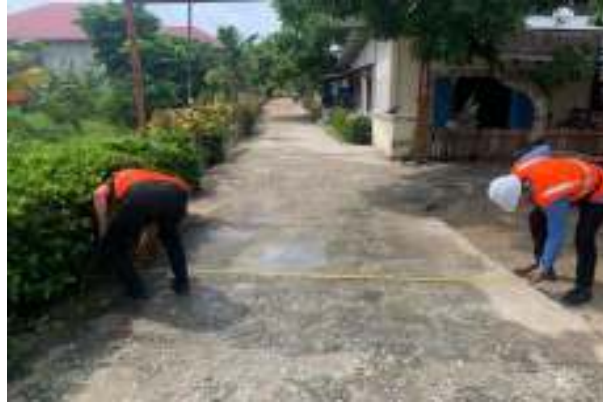
Gambar 4. 1 proses pengukuran jalan lingkungan
