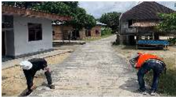
Gambar 4. 3 Pengukuran jalan Lingkungan
