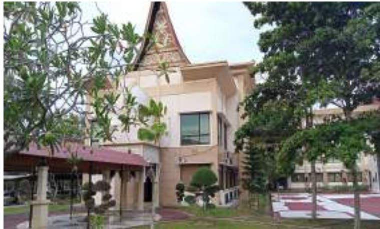
Gambar 5. 9 Split Levels pada Gedung Kantor Bidang Ekonomi, Pembangunan dan Kesra Kampar
