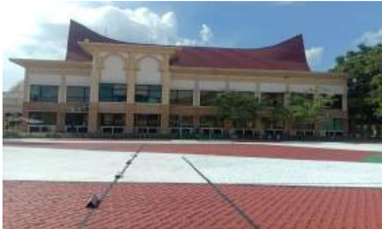
Gambar 5. 6 Gedung Kantor Bidang Ekonomi, Pembangunan dan Kesra Kampar
