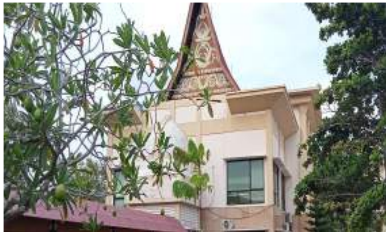
Gambar 5. 8 Parapets pada bagian atap Gedung Kantor Bidang Ekonomi, Pembangunan dan Kesra Kampar
