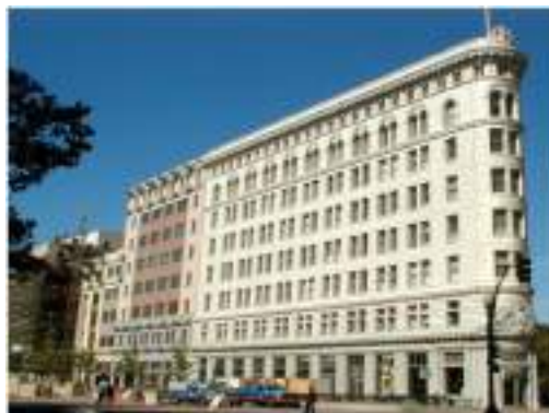
Gambar 3. 26 Ilustrasi bangunan tidak berparalel Sumber : (FEMA P-154, 2015)
