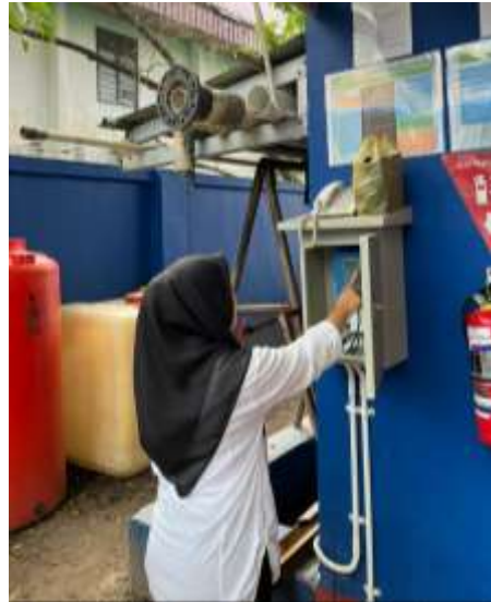
4. Pemantauan Instalasi Pengelolaan Air Limbah (IPAL)
