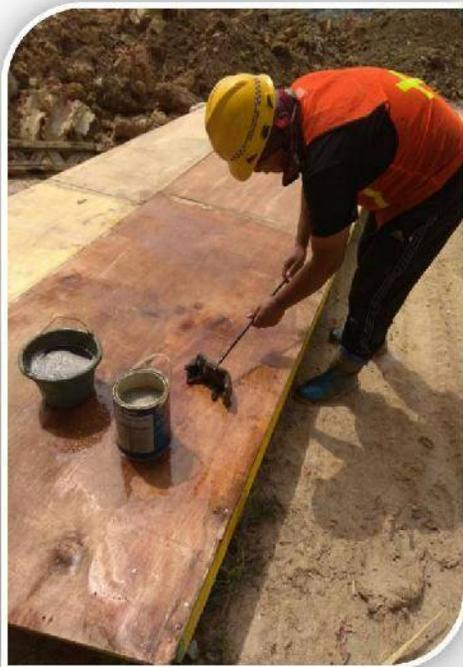
*Gambar 56.* Pelapisan begisting dalam menggunakan resin
