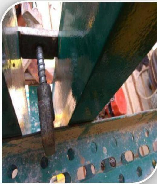
*Gambar 51. Pull push prop terhubung dengan waller*
