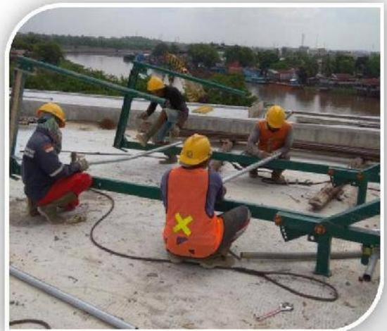
Gambar 15. Pemasangan *Suspended Platform*
