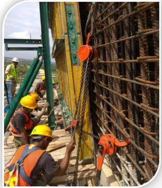
*Gambar 48. Pemasangan begisting luar dengan bantuan lever block dan chain block*
