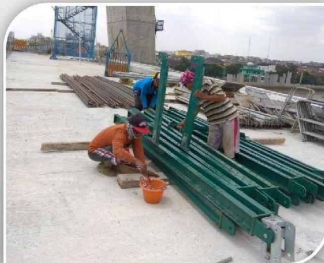
*Gambar 21. Pemasangan console bracket*
