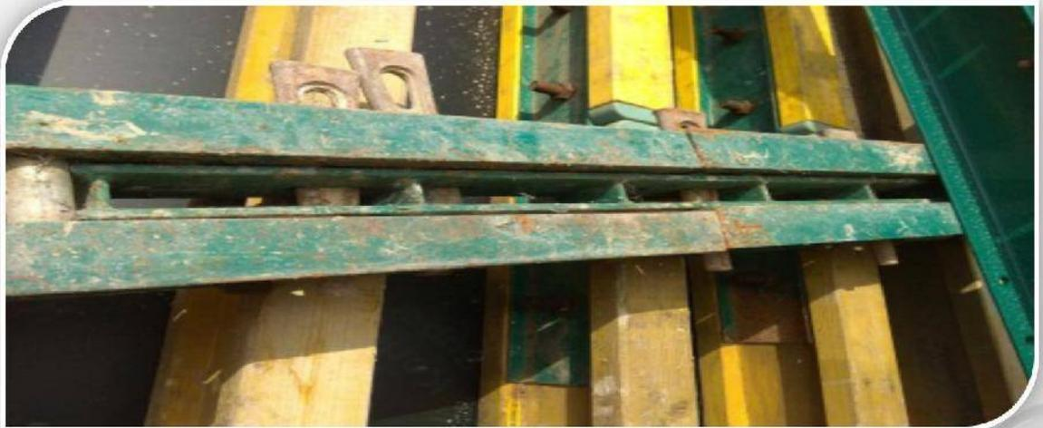
*Gambar 49. Pemasangan coupling sambungan antar begisting*
