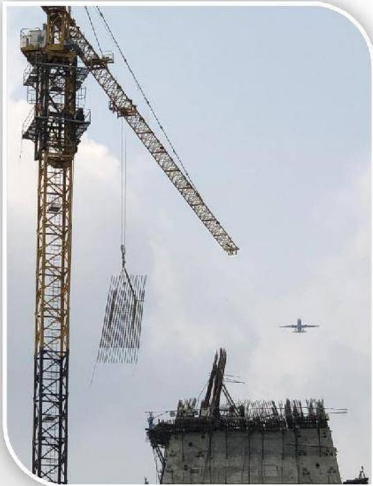
*Gambar 26. Pengangkatan besi tulangan yang telah dirakit*
