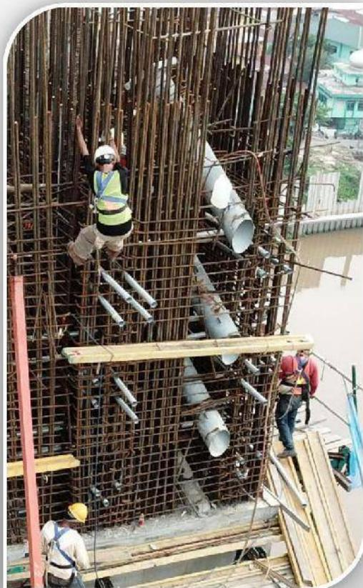
Gambar 33. Pemasangan guide pipe
