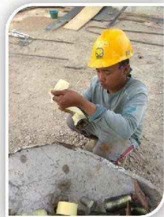
*Gambar 59.* Pengolesan Grease dan isolasi steel cone
