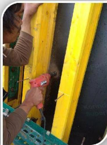
*Gambar 60.* Pengeboran begisting untuk pemasangan anchor bold
