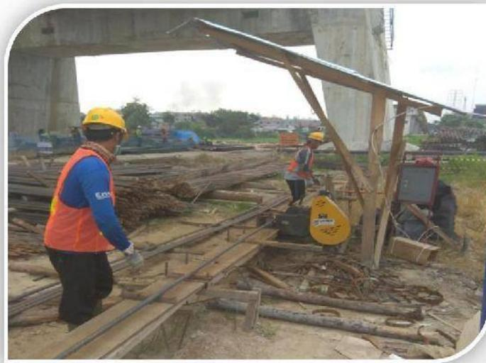
*Gambar 22. Pemotongan besi tulangan*
