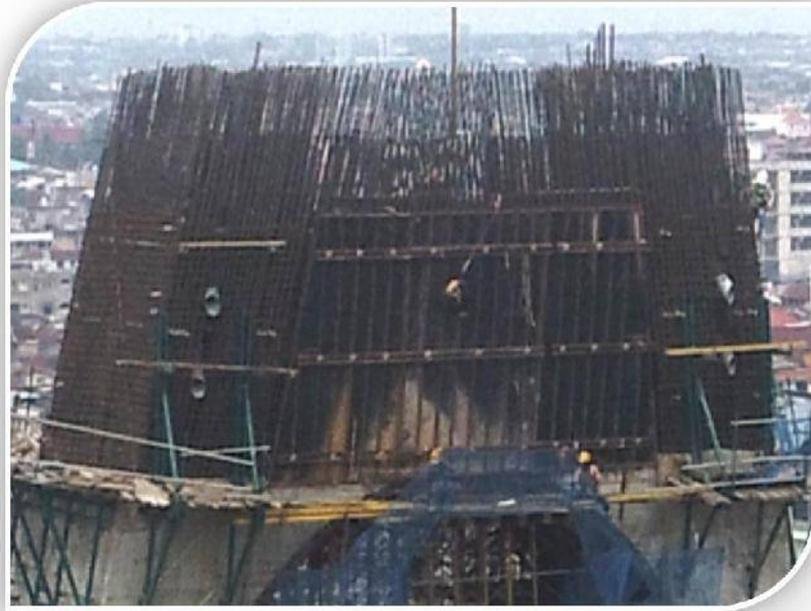
*Gambar 36. Besi Tulangan, Guide Pipe dan PT Bar terpasang*
