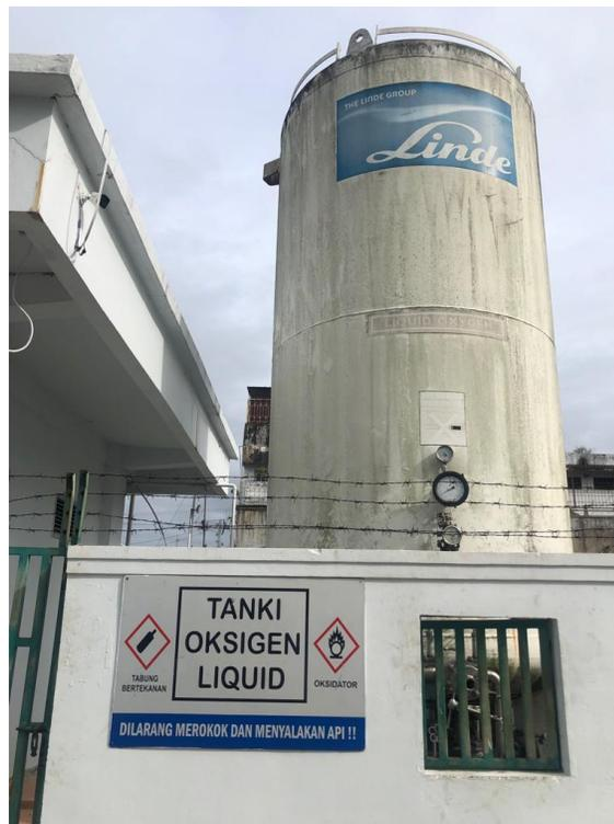
**Gambar 1. 11** Tanki oksigen liquid (Oksigen berbentuk air atau cairan)
