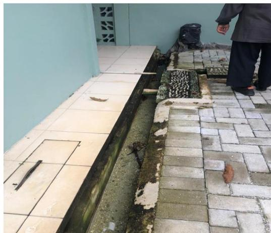
**Gambar 1. 28** Parit atau selokan yang di gunakan untuk membuang air hujan ke dreinase kota. Sedangkan air kamar mandi atau limbah lainnya akan di alirkan ke IPAL (Instalasi Pengolaan Air Limbah)
