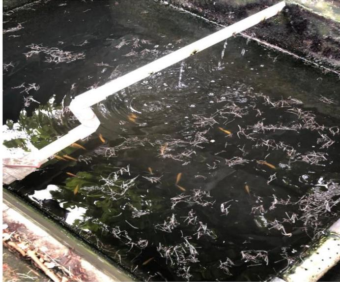
**Gambar 1. 18** Kolam uji yang berfungsi untuk menguji kualitas air limbah yang sudah melalui proses Instalasi Pengolahan Air Limbah (IPAL) sebelum di buang ke drainase kota, di dalam kolam uji ini terdapat ikan. Jika ikan yang berda di dalam kolam uji ini mengalami mas
