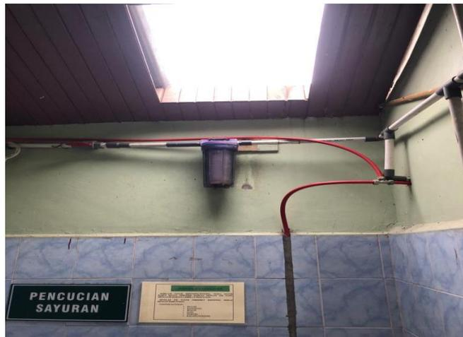
**Gambar 1. 24** Penyaringan air bersih sebelum di gunakan untuk mencuci bahan pangan yang akan di olah oleh para ahli gizi untuk para pasien di Rumah Sakit Islam Ibnu Sina Pekanbaru.
