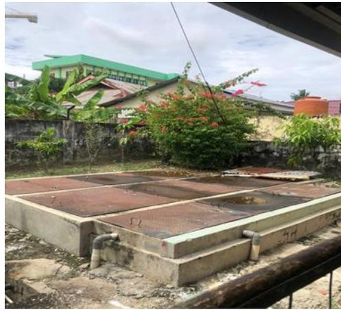
**Gambar 1. 20** Bak pengendapan awal, sebelum masuk ke IPAL air limbah dari setiap ruangan yang ada di Rumah Sakit Islam Ibnu Sina Pekanbaru terlebih dahulu masuk kedalam bak pengendapan awal.
