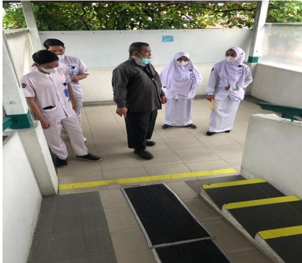
**Gambar 1. 27** Alternatif menuju kelantai 2 untuk pasien dan pengunjung, tangga digunakan untuk pengunjung atau petugas RS. Sedangkan tangga khusus yang berbentuk seperti tanjakan digunakan untuk pasien jika menggunakan kursi roda dll.
