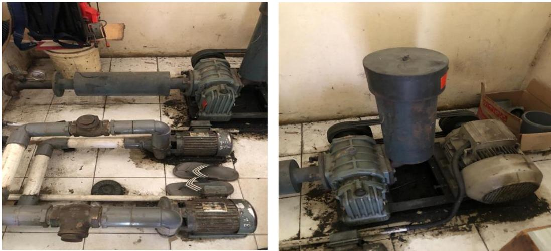
**Gambar 1. 22** Mesin pompa IPAL yang bertujuan untuk melakukan proses peoperasian IPAL (Instalasi Pengolaan Air Limbah) secara berskala.
