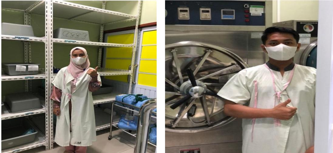
**Gambar 1. 29** Rak penyimpanan barang yang Steril dan Autoclaf. Rak penyimpanan barang yang sudah di sterilkan harus memenuhi standar yang sudah di tentukan yaitu 20 cm-24 cm dari lantai, 40 cm dari langit-langit dan 6 cm dari dinding. Sedangkan Autoclaf merupakan ala
