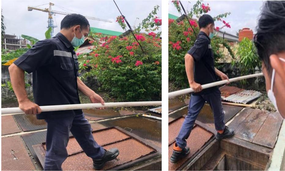
**Gambar 1. 23** Pembersihan pada bak penampungan awal IPAL yang di lakukan oleh pihak IPSRS.
